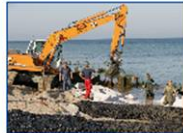
Pilotprojekt Sylter Elbdegen: Seit September 2005 wird ein Deichwest mit Elastocoast® an diesem besonders gefährdeten Küstenabschnitt geprüft.
